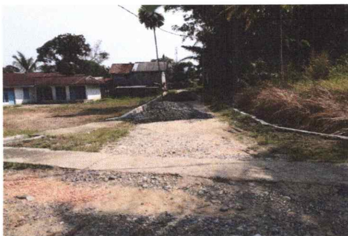
JALAN BETON R2
