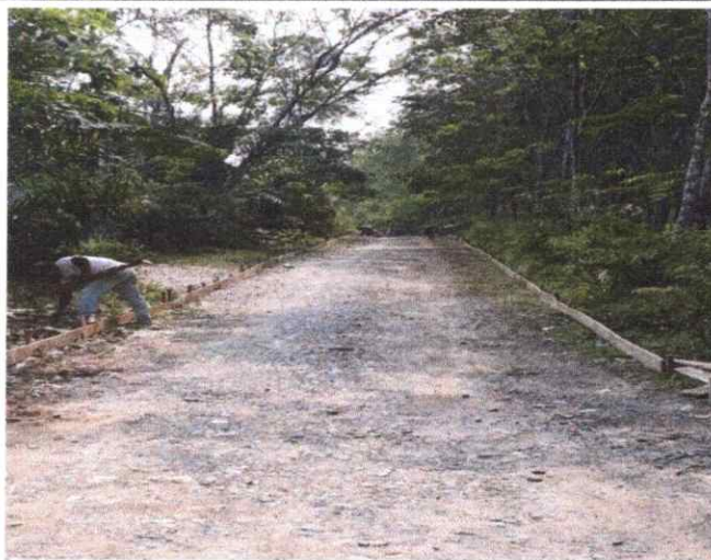
JALAN BETON R8
