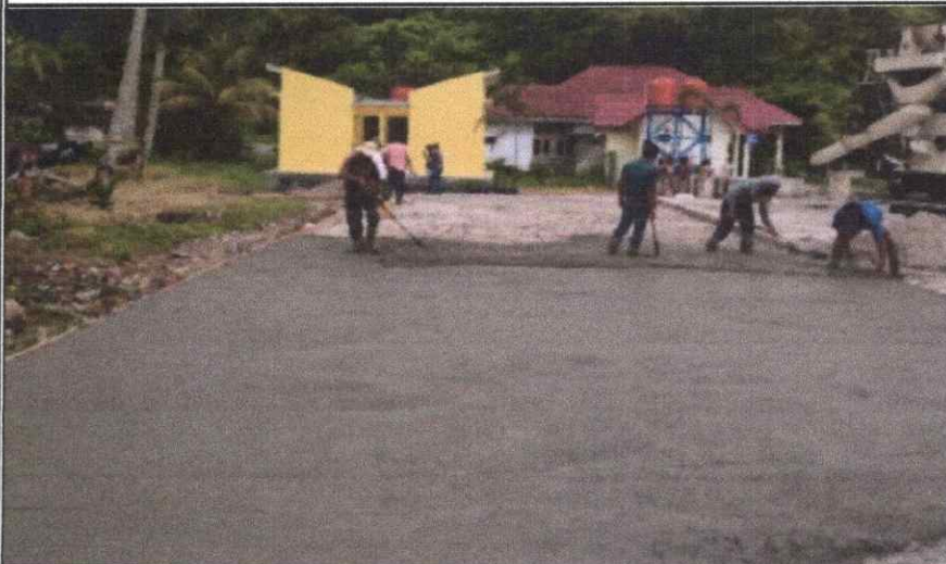
Pekerjaan Beton Lantai Parkir K.300 (Ready Mix)
