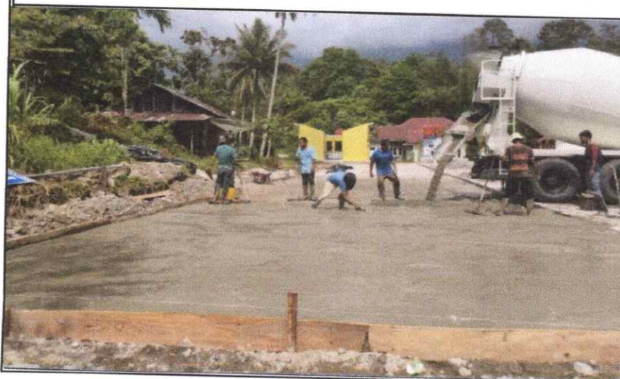
Pekerjaan Beton Lantai Parkir K.300 (Ready Mix)
