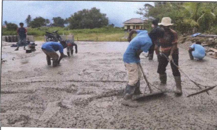
Pekerjaan Beton Lantai Parkir K.300 (Ready Mix)
